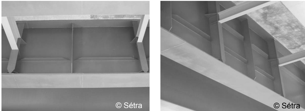
Abbildung 5-6: Plattenbalkenbrücke in Triel-sur-Seine, Frankreich, 2003.
