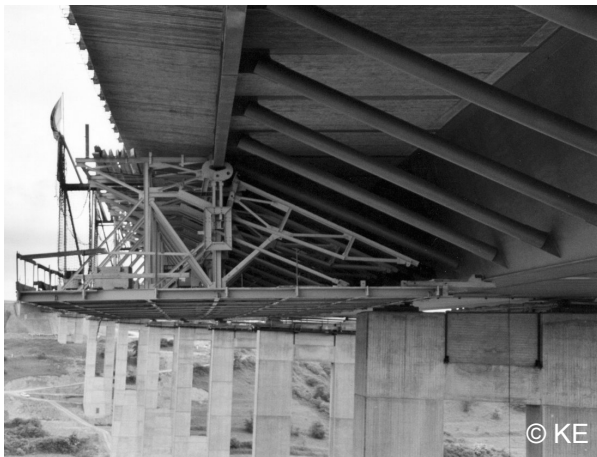
Abbildung 2-39: Abklappbare, äußere Schalung, Talbrücke bei Schwarza, Deutschland, 2002.
