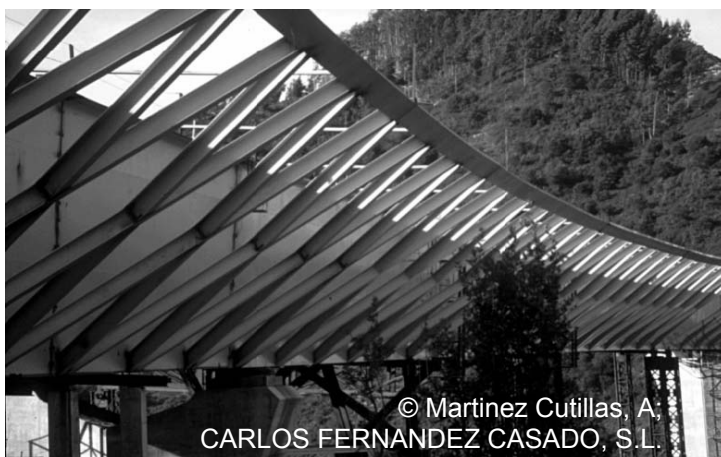
Abbildung 2-54: Seitlicher Fachwerkträger der Talbrücke Tina Menor [56].
