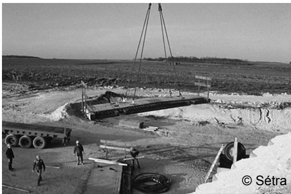
Abbildung 2-22: Einsatz von Betonfertigteilen für die Fahrbahnplatte.
