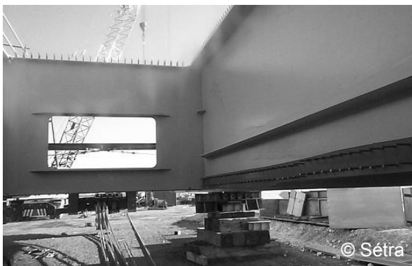
Abbildung 6-4: Eisenbahnbrücke mit Querschott auf der TGV-Strecke nach Osten über den Ourcq-Kanal, Frankreich, 2006.
