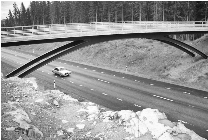
Abbildung 2-69: Brücke über die Nationalstraße E4 bei Höga Kusten, Schweden.
