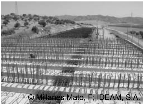
c) Halbfertigteilplatten des Obergurts
