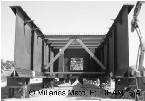
a) Zweistegiger Plattenbalken mit angepasstem Querschnitt
