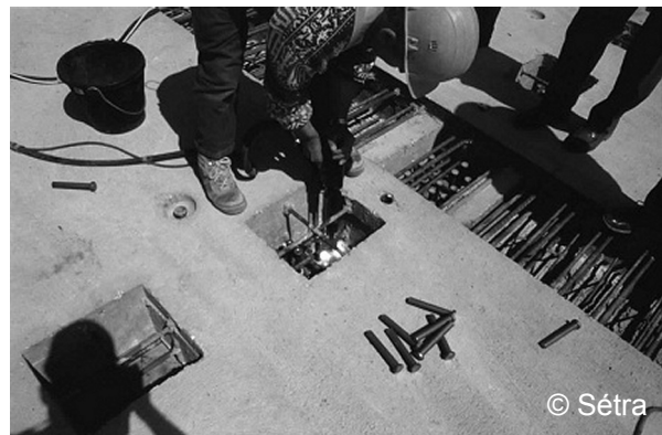
Abbildung 2-22: Einsatz von Betonfertigteilen für die Fahrbahnplatte.
