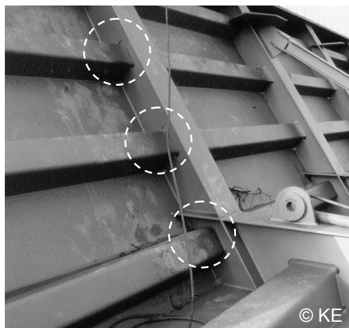
Abbildung 5-9: Konstruktionsdetail des Verschneidungspunktes von Längs- und Quersteife.
