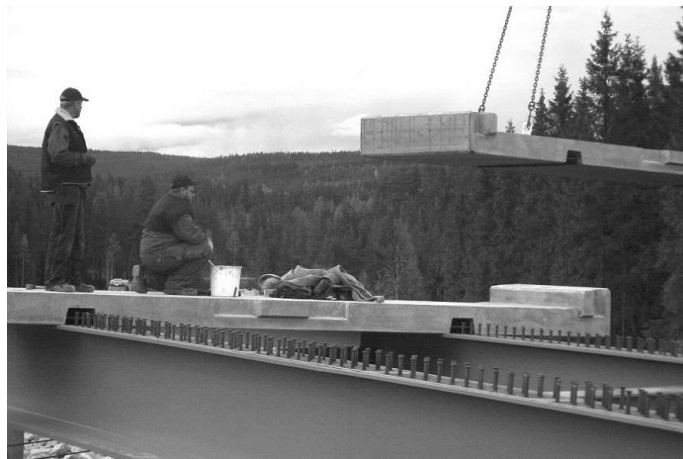
Abbildung 2-65: Montage eines Fahrbahnplattenelements.
