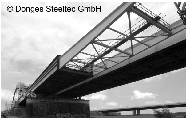
Abbildung 5-12: Einschub der Eisenbahnbrücke bei Riesa, Deutschland, 2005.
