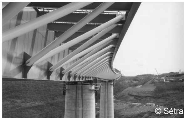
Abbildung 2-2: Kastenquerschnitt mit Schrägstreben und Außenlängsträgern zur Unterstützung der Fahrbahnplatte (Verrières-Viadukt bei Millau, Frankreich, 2002).
