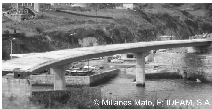
c) Puente sobre la Ría de Ciérvana, Bilbao, 1978 (weltweit erstes veröffentlichtes Beispiel mit Doppelverbundquerschnitt).
