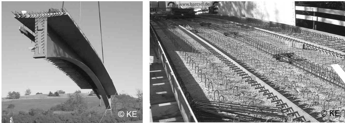
Abbildung 2-46: Montage eines Verbundfertigteilträgers mit liegenden Kopfbolzendübeln bei Münsingen, Deutschland.
