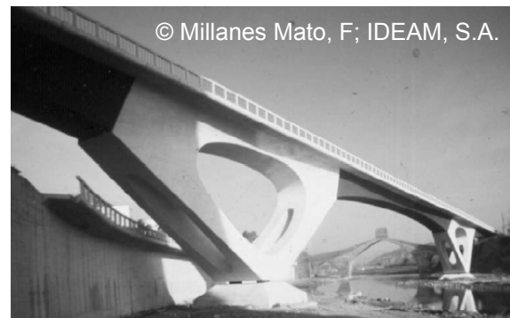
b) Puente del Diablo, Barcelona, 1972 (100 m Spannweite, zwei dreiecksförmige Hohlkästen).
