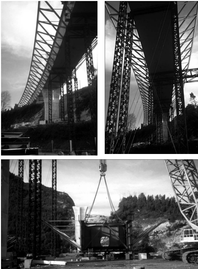
Abbildung 2-55: Hilfsstützen beim Bau der Talbrücke Tina Menor [56].
