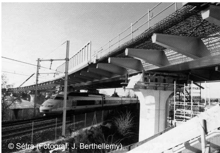
Abbildung 7-10: Einschub der Brücke Croix Verte über eine Bahnlinie bei Avignon, Frankreich, 1994.
