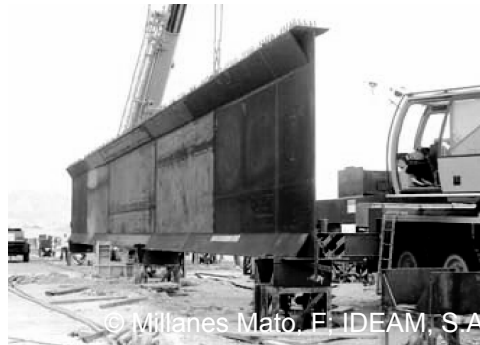
b) Hauptträger mit dreiecksförmigen Hohlkästen
