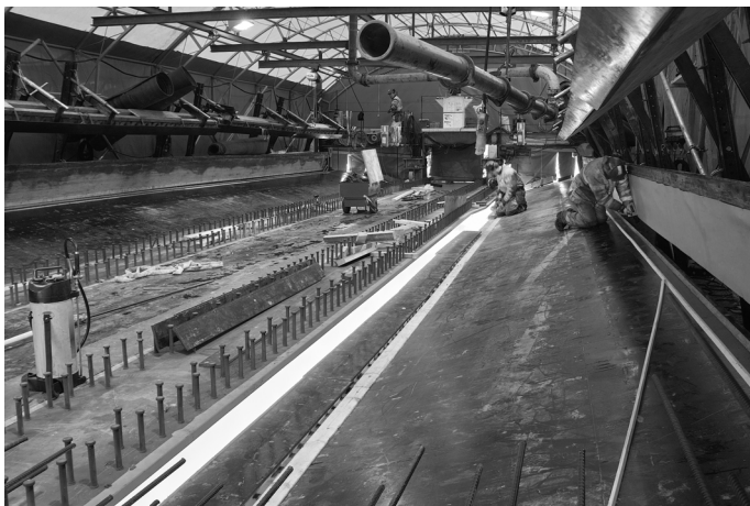
Abbildung 2-68: Brücke über den Veckefjärden während der Errichtung im Winter.
