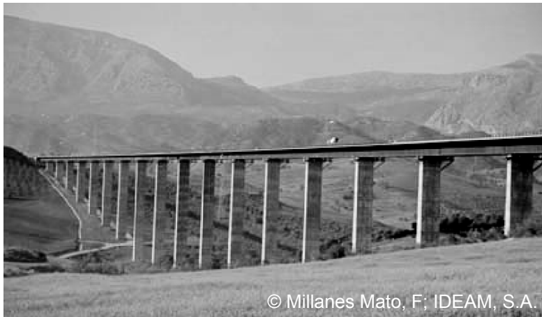
Abbildung 2-56: Talbrücke Arroyo de las Piedras [61].
