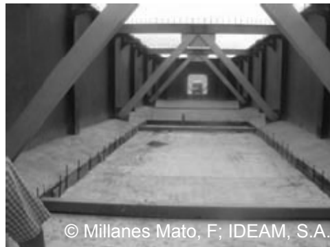
d) Halbfertigteilplatten mit Ortbetonergänzung im Untergurt.
