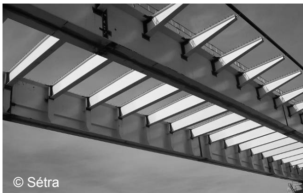
Abbildung 6-3: Zweistufige Plattenbalkenbrücke bei Avignon, Frankreich, 2008.
