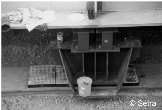
Abbildung 7-7: An der Position einer Quersteife befestigter Verschubschlitten, Verrières Viadukt bei Millau, Frankreich, 2002.
