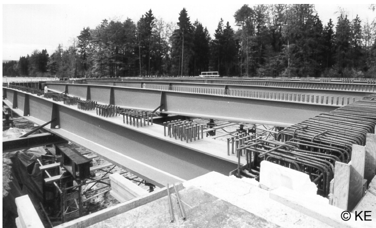
Abbildung 2-44: Bau einer Brücke mit Stahlträgern und Großflächenschalelemente bei Ravensburg, Deutschland.
