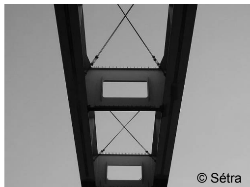
Abbildung 6-6: Eisenbahnbrücke (östliche TGV-Linie) bei Pont à Mousson, Frankreich.
