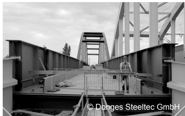
Abbildung 5-12: Einschub der Eisenbahnbrücke bei Riesa, Deutschland, 2005.
