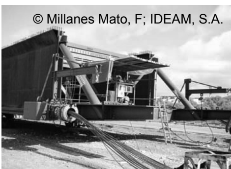
b) Ansicht der Hilfskonstruktion zum Einschleiben mit Spannseilen und Hydraulikzylindern.
