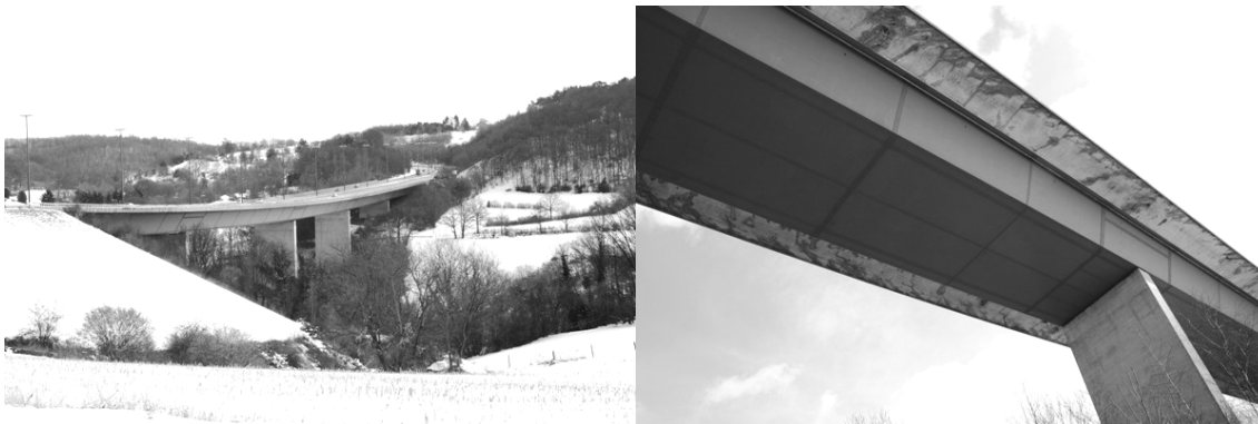
Abbildung 2-16: Talbrücke bei Polleur, Belgien.
