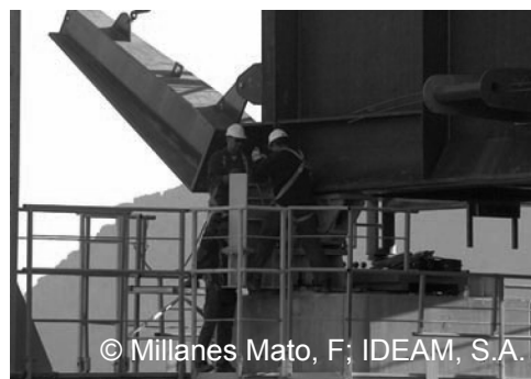
c) Arbeitsvorgang während des Überschiebens der Stütze und Anheben des Verschiebepinsels.
