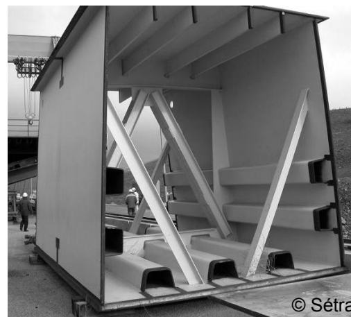
Abbildung 4-3: Kastenquerschnitt mit Trapezhohlsteifen des Millau-Viadukts, Frankreich.
