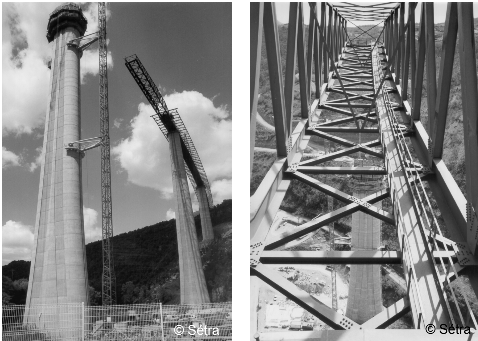
Abbildung 7-9: Vorbauschnabel des Verrières-Viadukts bei Millau, Frankreich, 2002.
