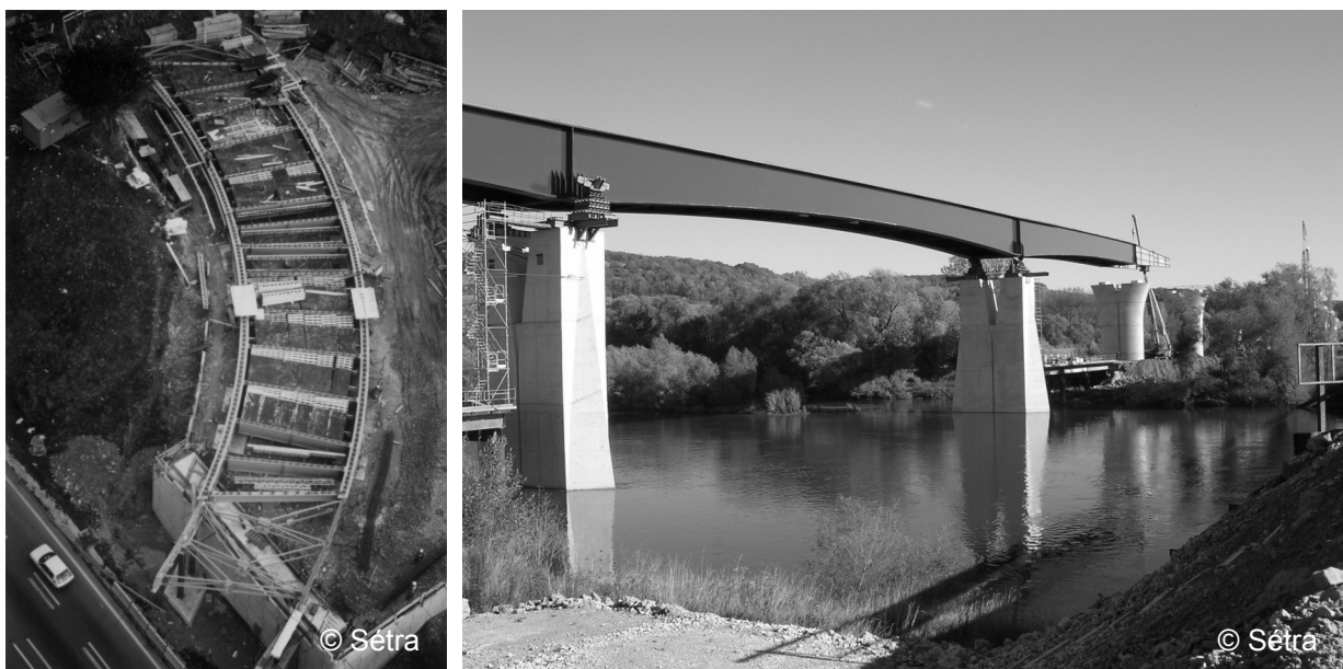
a) Im Grundriss gekrümmte Brücke bei Cannes, Frankreich. b) Brücke mit gevoutetem Balken bei Pont-à-Mousson, Frankreich.
