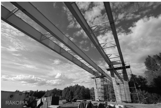
Abbildung 2-61: Bau der Brücke bei Rångedala, Schweden.
