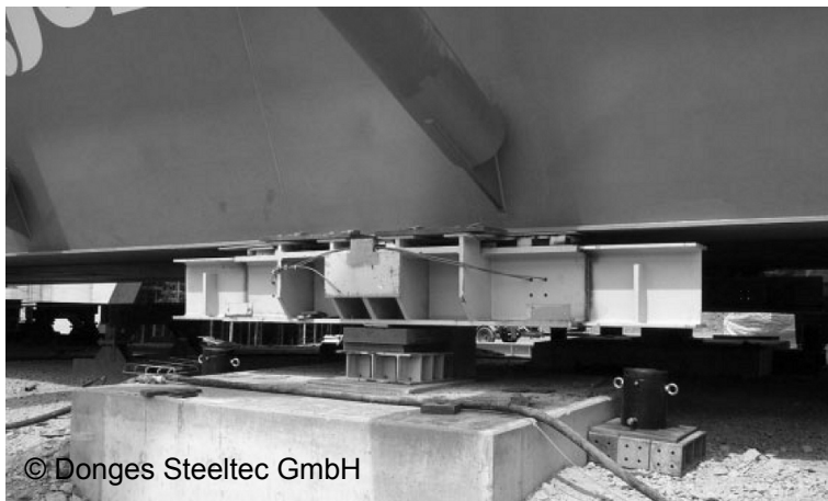
Abbildung 7-6: Vershubwippe mit seitlichen Führungsschienen, Talbrücke Elben bei Siegen, Germany, 2005.
