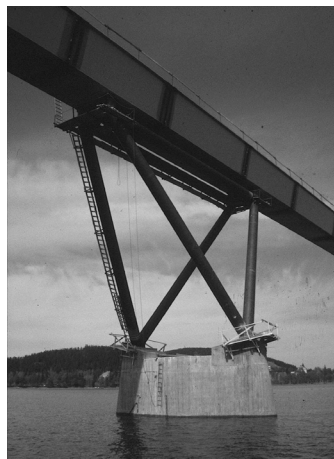
Abbildung 2-70: Brücke über den Vallsundet, Schweden, und gespreiztes Auflager nahe der Fahrrinne.
