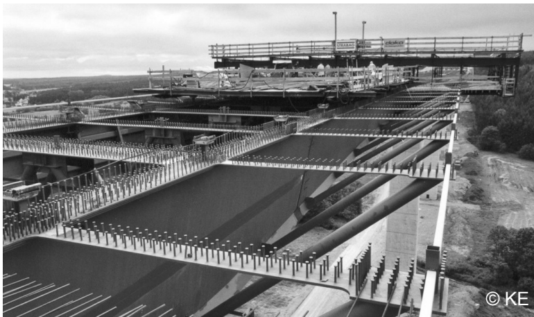
Abbildung 2-37: „Stühlchen“ als Auflagerpunkte für den obenfahrenden Schalwagen, Talbrücke Reichenbach bei Ilmenau, Deutschland, 2002.
