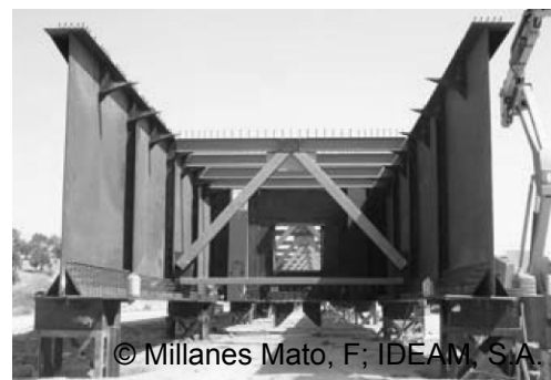
Abbildung 6-2: Fachwerk als Queraussteifung.
