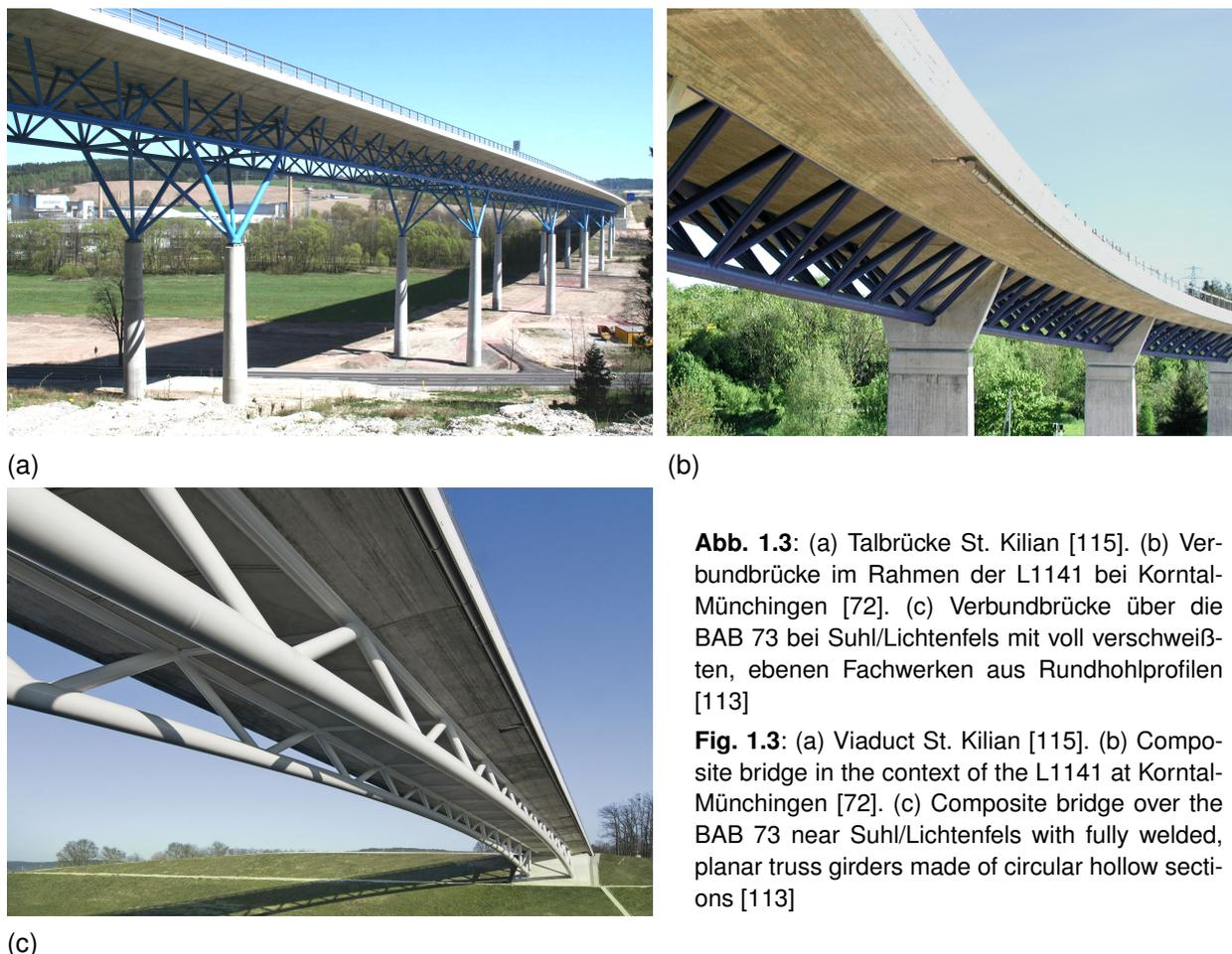
**Abb. 1.3:** (a) Talbrücke St. Kilian [115]. (b) Verbundbrücke im Rahmen der L1141 bei Korntal-Münchingen [72]. (c) Verbundbrücke über die BAB 73 bei Suhl/Lichtenfels mit voll verschweißten, ebenen Fachwerken aus Rundhohlprofilen [113]
